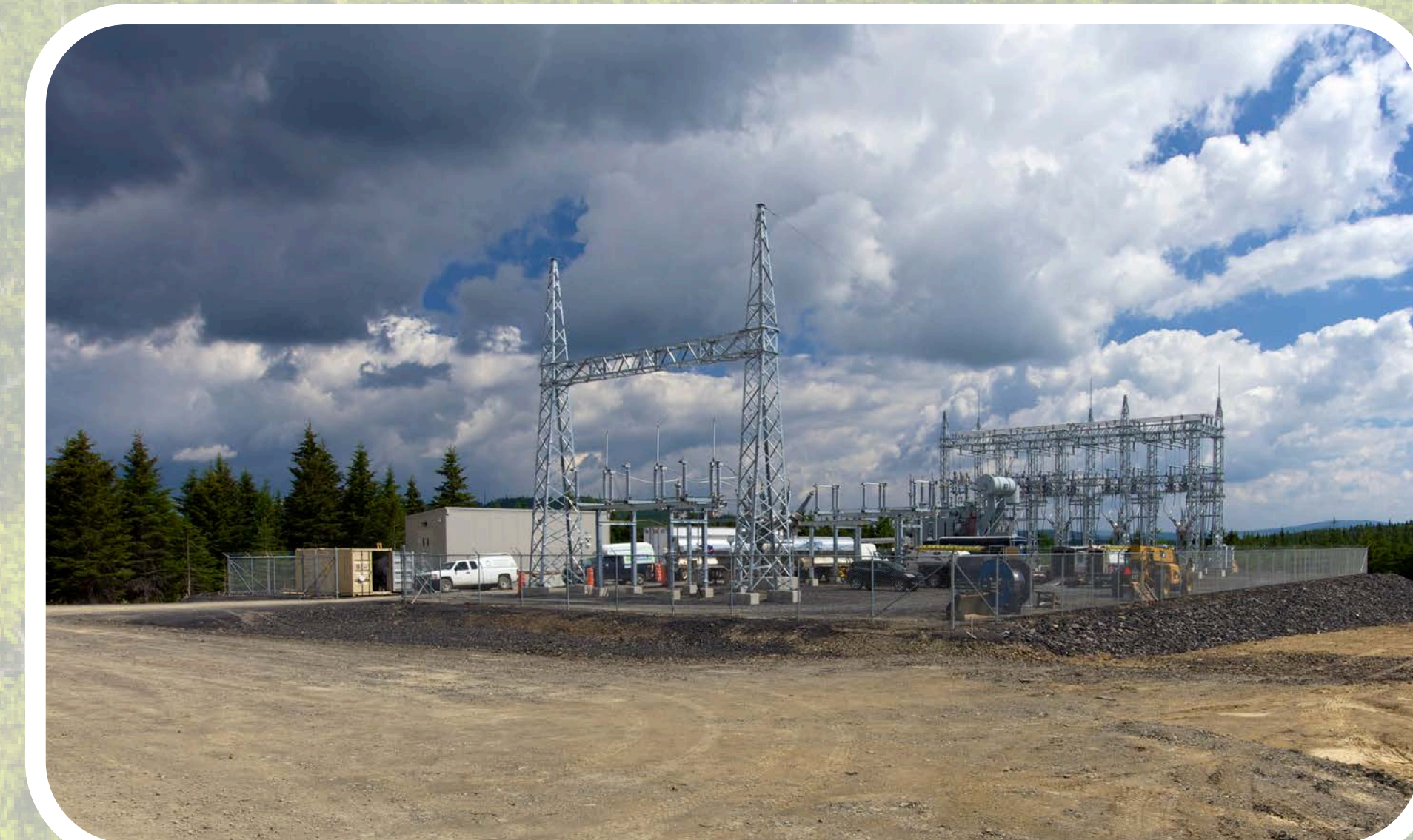
Substation construction du poste
